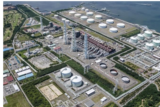
主に新潟県に電気を送っている東北電力東新潟火力発電所
