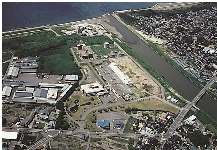
自然環境浄化センター(安政町)
