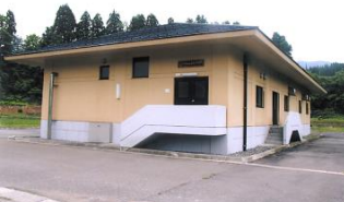
岡田地区処理場
